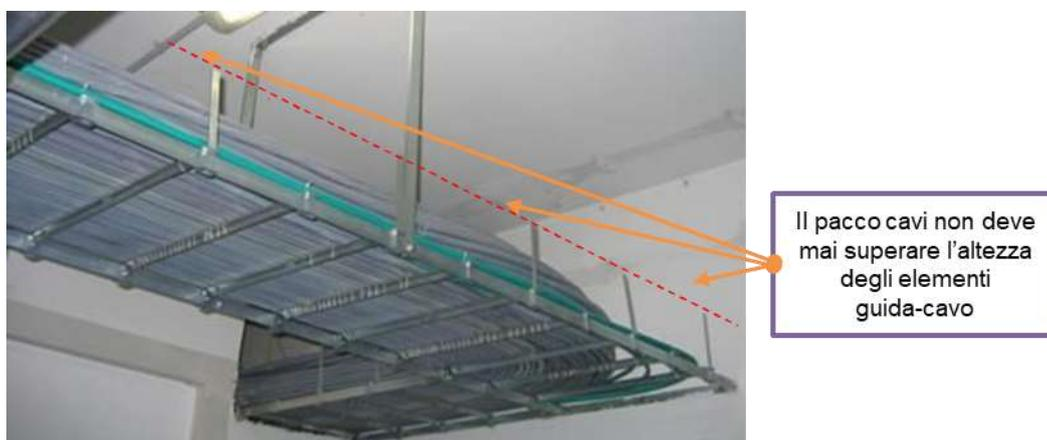
Figura 24 Esempio di occupazione del supporto cavi
