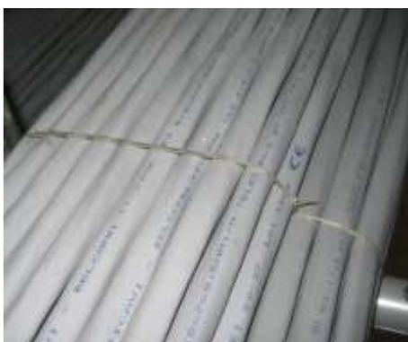
Figura 29 Dettaglio di legatura a “Fascio”
