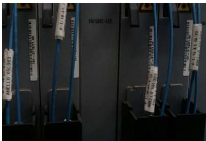
Figura 108 – Modalità di Etichettatura delle bretelle F.O.
