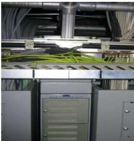
Figura 82 - Attestazione dello schermo del cavo di alimentazione su strutture con distribuzione a montante
