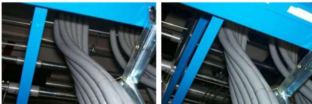
Figura 23 Esempio di posa dei cavi a elica
