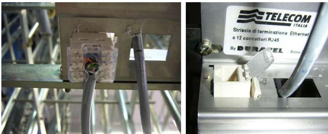
Figura 66 – montaggio connettore su supporto striscia
