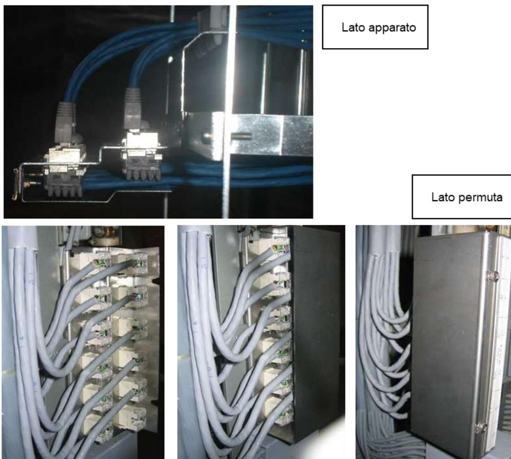
Figura 60 – Esempio di sagomatura cavi sul lato verticale
