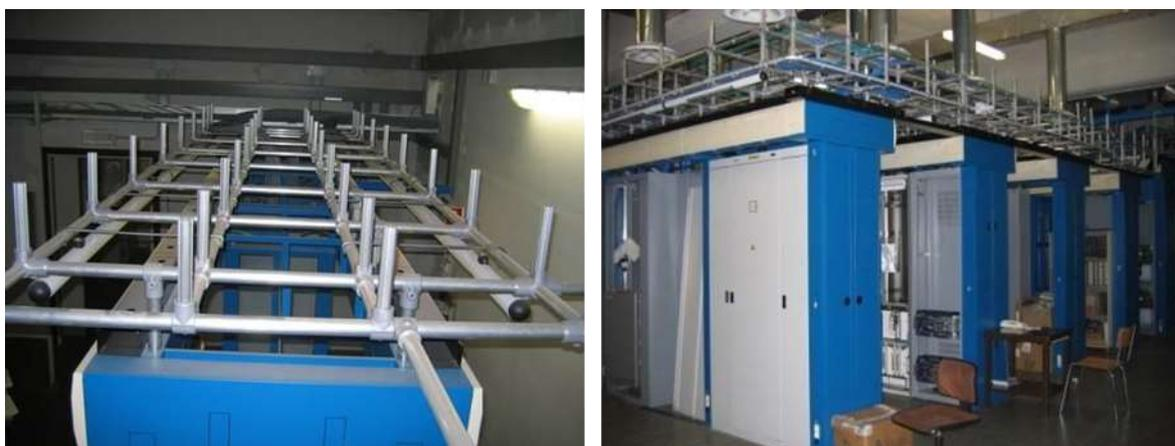
Figura 4 Planare tubolare da 35 mm ad un livello e a due livelli
