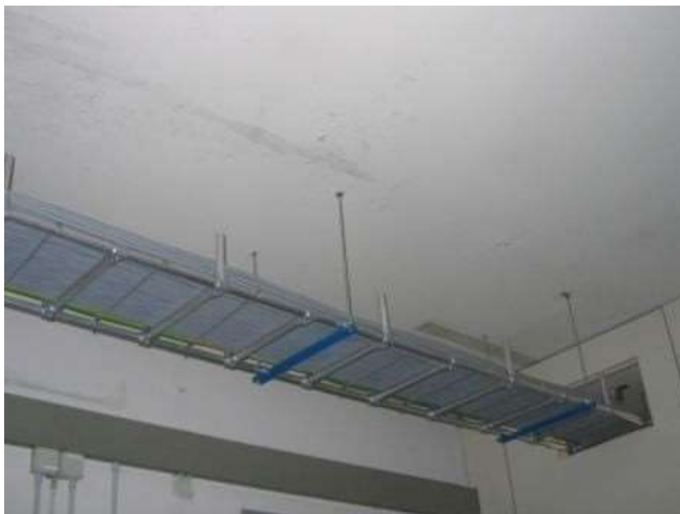
Figura 5 Passatoia Doppia aperta Tubolare Orizzontale diametro 35mm
