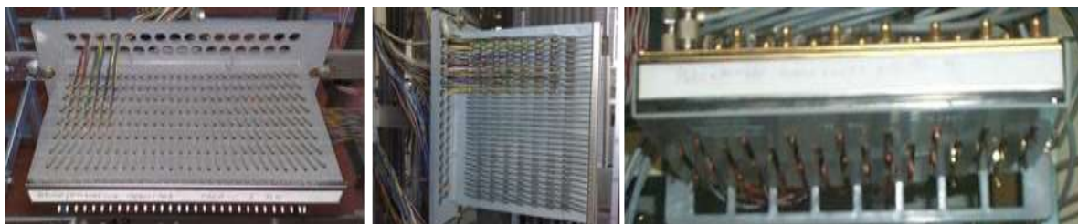
Figura 57 – Esempi di Strisce che utilizzano la connessione avvolta WW (a sx due esempi di Striscia S6 30 x 8; a dx Striscia Balun: lato coassiale sopra, lato wire wrap sotto)
