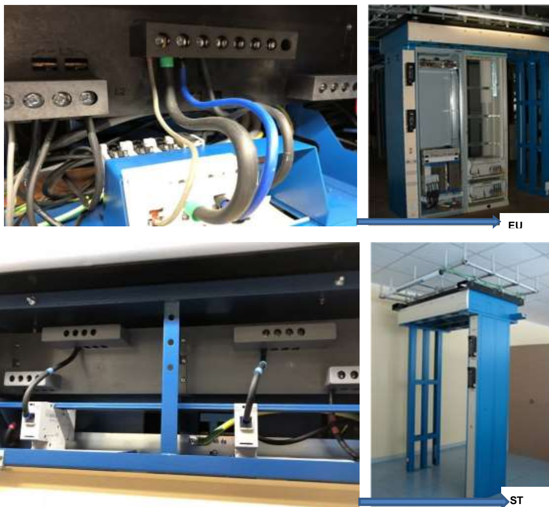
Figura 71 - Posa cavi di alimentazione su alcuni tipi di strutture di centrale
