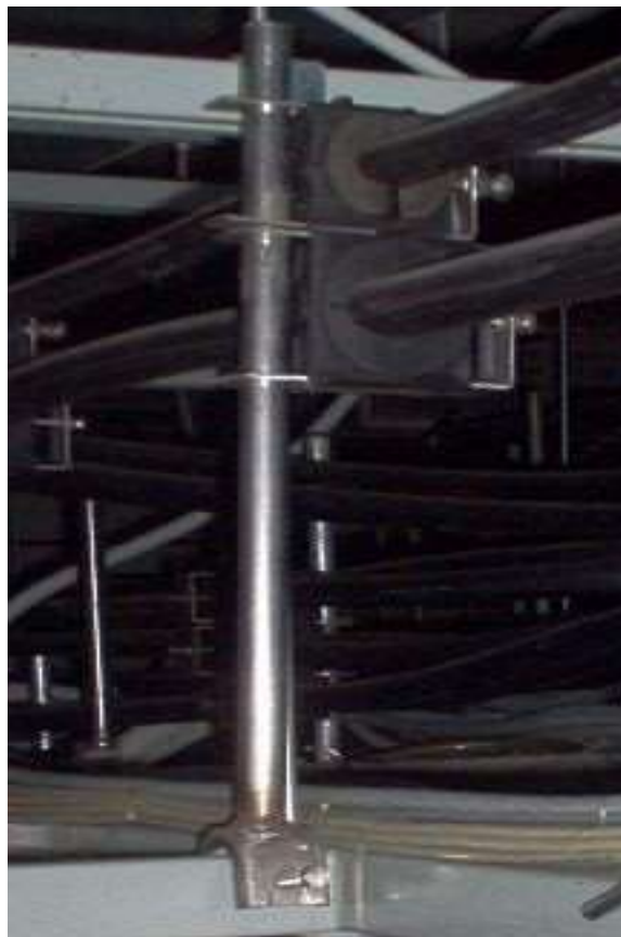
Figura 38 Supporto singolo per G.O.
