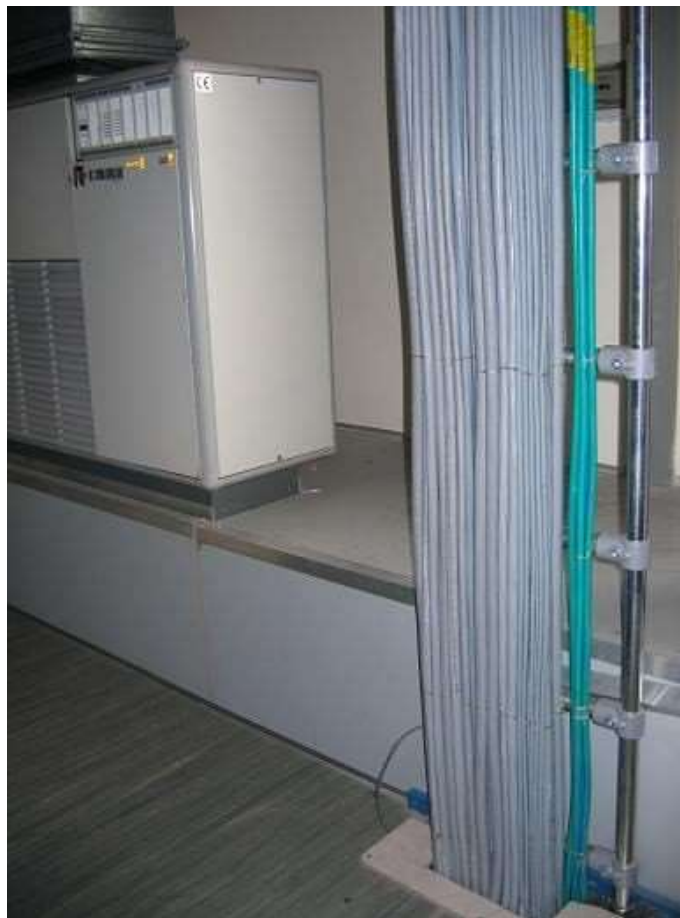
Figura 6 Passatoia Doppia aperta Tubolare Verticale diametro 35mm
