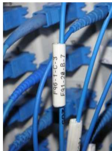
Figura 107 Es. di Colleg.to Rip Ottico-Rip
