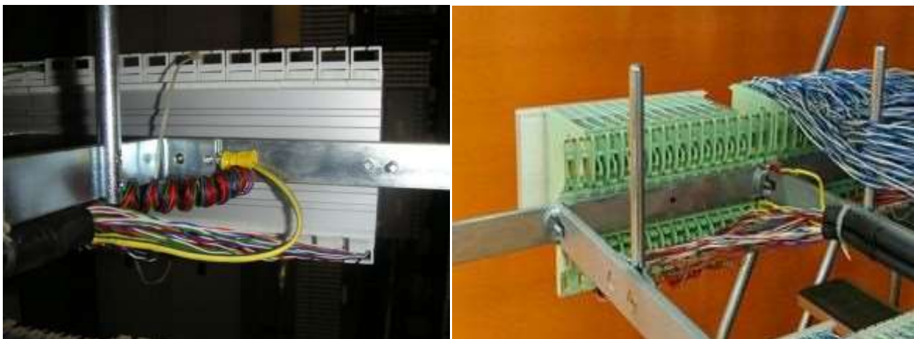
Figura 43 – A sinistra coppie di scorta avvolte in un'unica spirulina dietro la striscia IDC per cablaggi OAO. A destra vista posteriore della striscia ADSL al Permutatore
