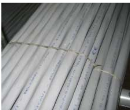
Figura 29 Dettaglio di legatura a “Fascio”
