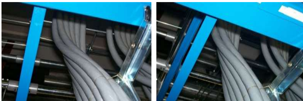
Figura 23 Esempio di posa dei cavi a elica
