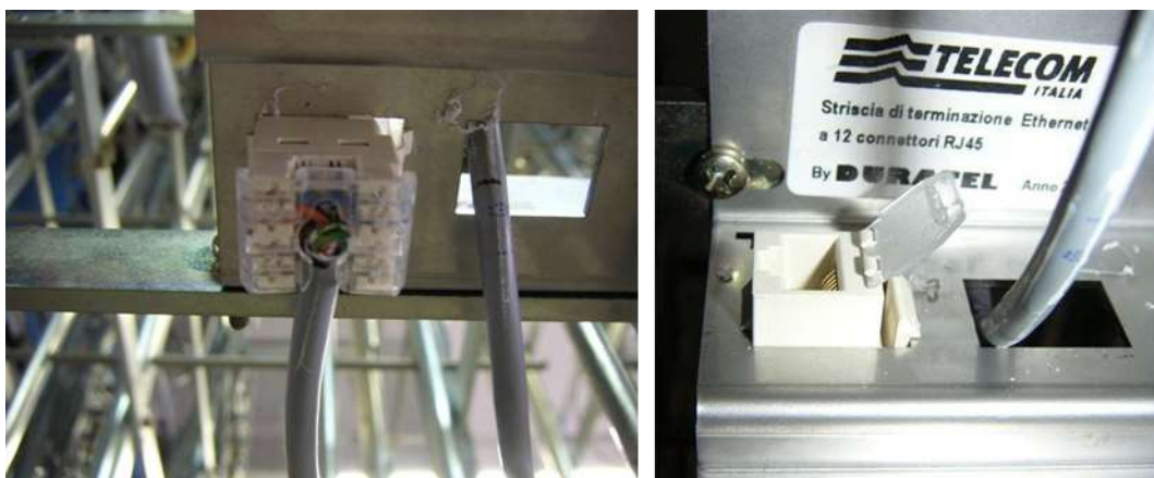
Figura 66 – montaggio connettore su supporto striscia
