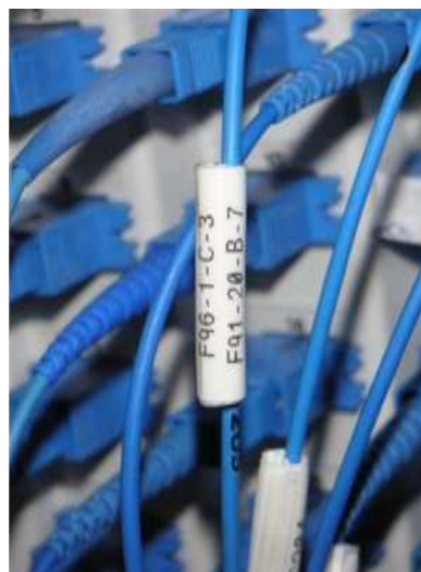
Figura 107 Es. di Colleg.to Rip Ottico-Rip
