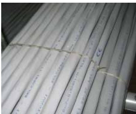
Figura 29 Dettaglio di legatura a “Fascio”
