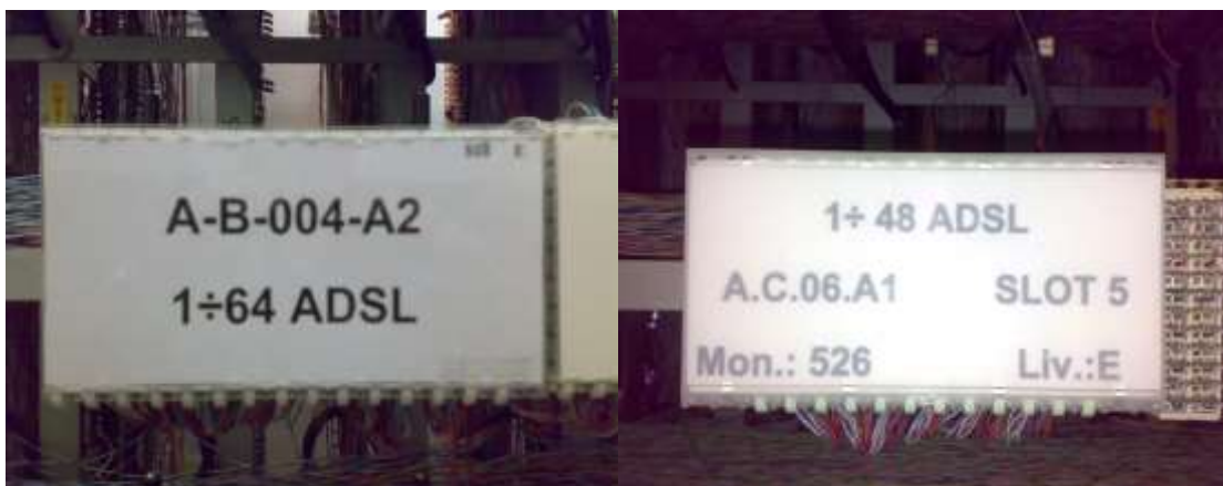
Figura 104 – Esempio di cartellini striscia per attestazione ADSL
