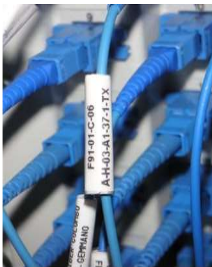
Figura 106 Es. Colleg.to Rip Ottico-Apparato
