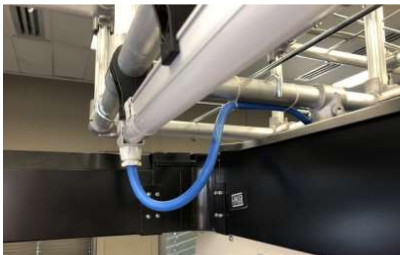
Figura 73 - Posa cavi di alimentazione doppio isolamento legato sotto il planare
