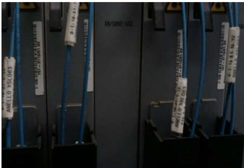
Figura 108 – Modalità di Etichettatura delle bretelle F.O.
