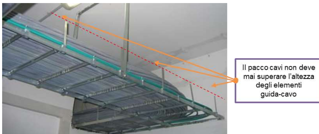
Figura 24 Esempio di occupazione del supporto cavi
