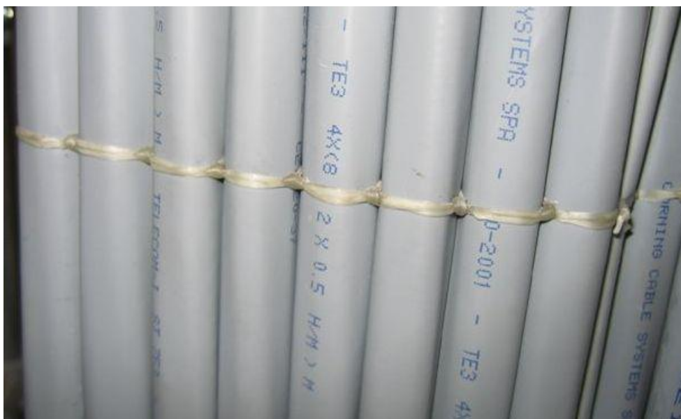
Figura 34: Dettaglio di legatura a “Pacco”
