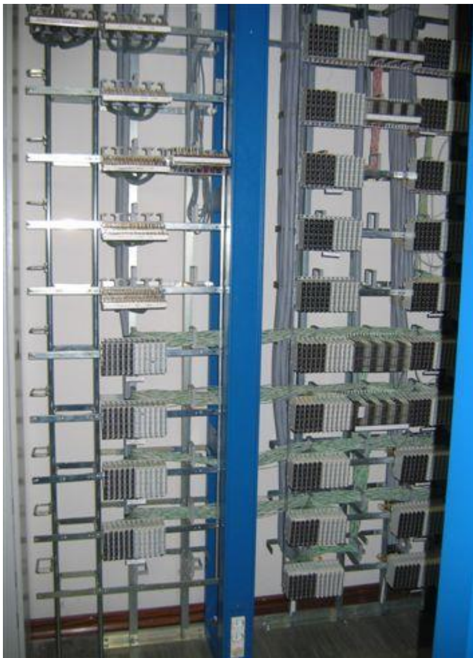
Figura 20: Ripartitore elettrico monofronte 10 livelli
