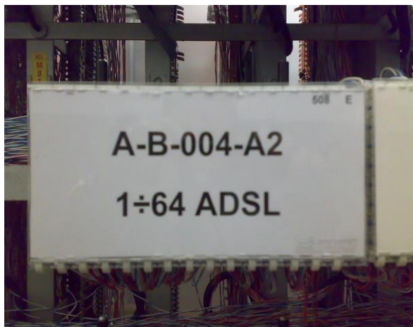
Figura 69: Esempio di cartellini striscia per attestazione ADSL
