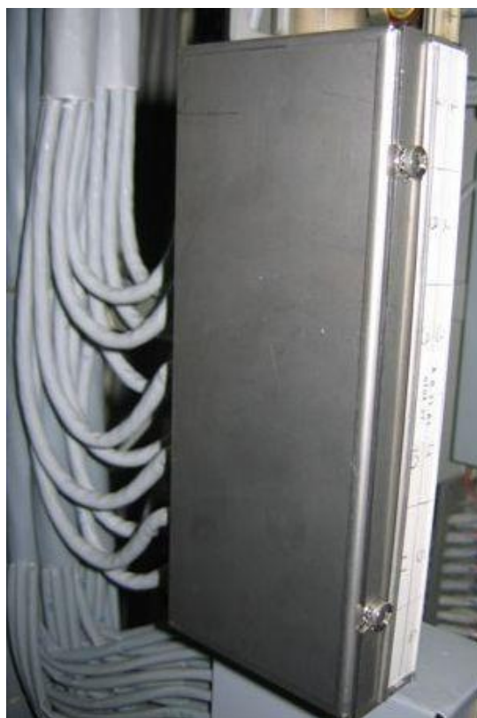
Figura 59: Esempio di sagomatura cavi sul lato verticale
