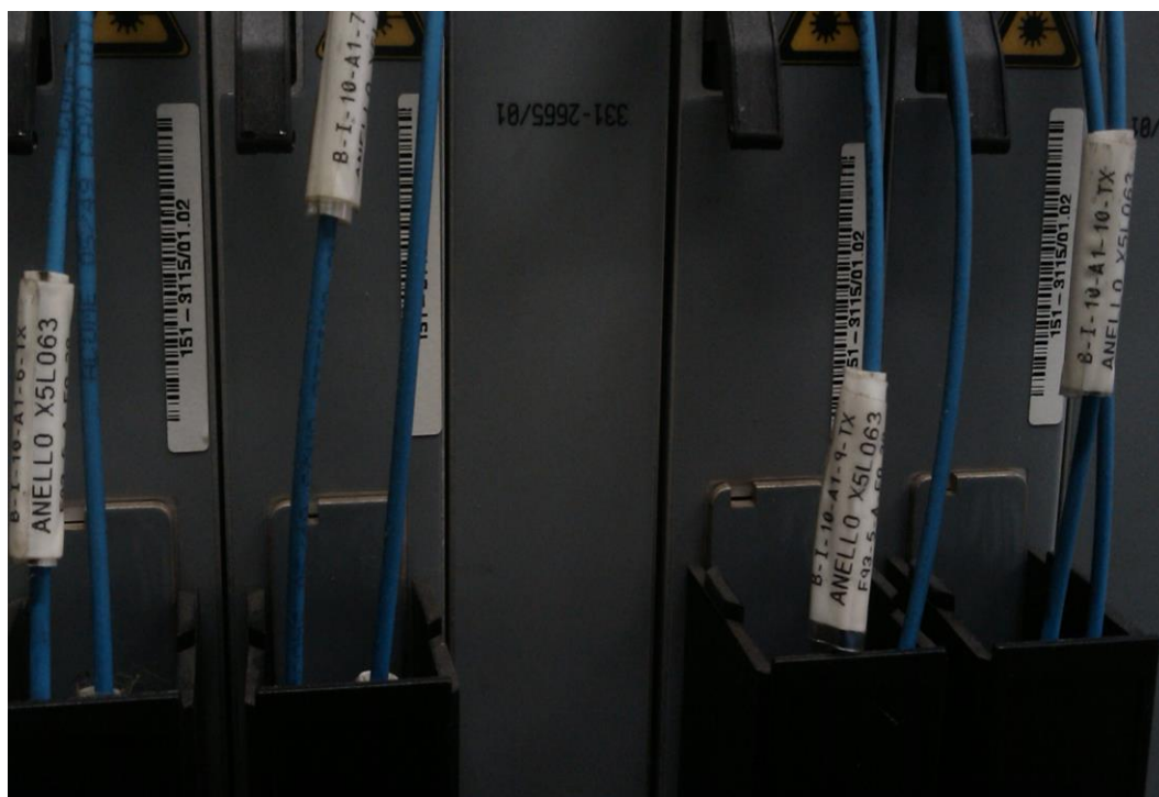
Figura 71: Modalità di Etichettatura delle bretelle F.O.
