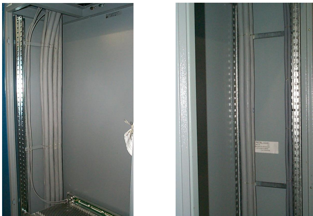
Figura 32: Legatura a “Fascio” interna alle fiancate del telaio
