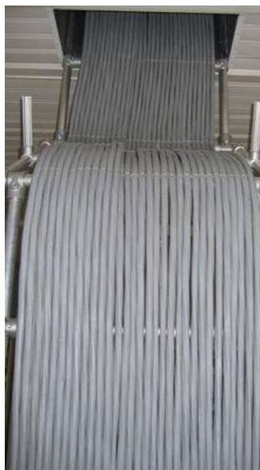
Figura 24: Esempio di posa orizzontale e verticale con pacco cavi omogeneo e compatto
