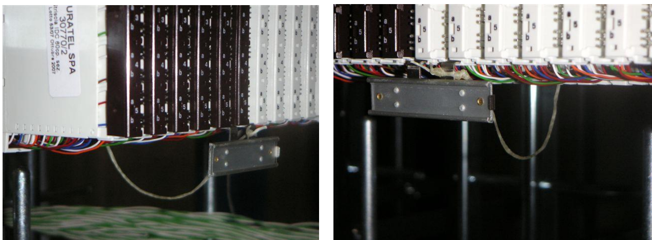
Figura 70: Modalità di legatura, con spago cerato, del portacartellino della striscia
