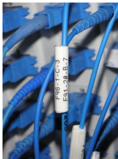
Esempio di Collegamento Rip. Ottico – Rip. Ottico
