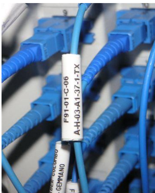
Esempio di Collegamento Rip. Ottico – Apparato
