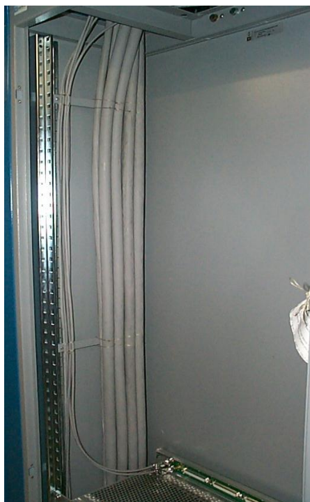
Figura 32: Legatura a “Fascio” interna alle fiancate del telaio
