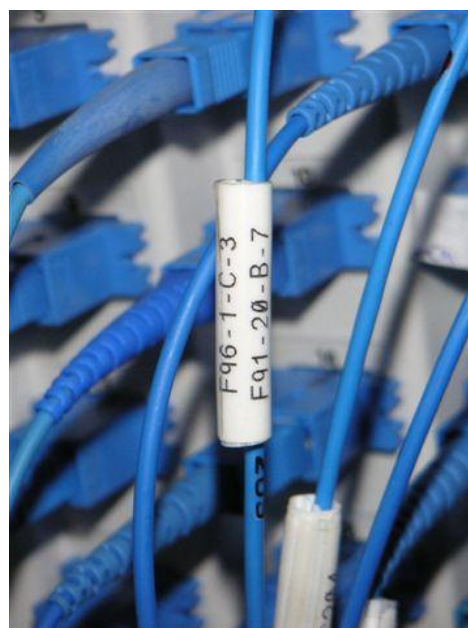
Esempio di Collegamento Rip. Ottico – Rip. Ottico
