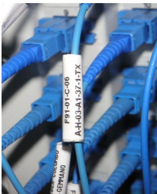
Esempio di Collegamento Rip. Ottico – Apparato
