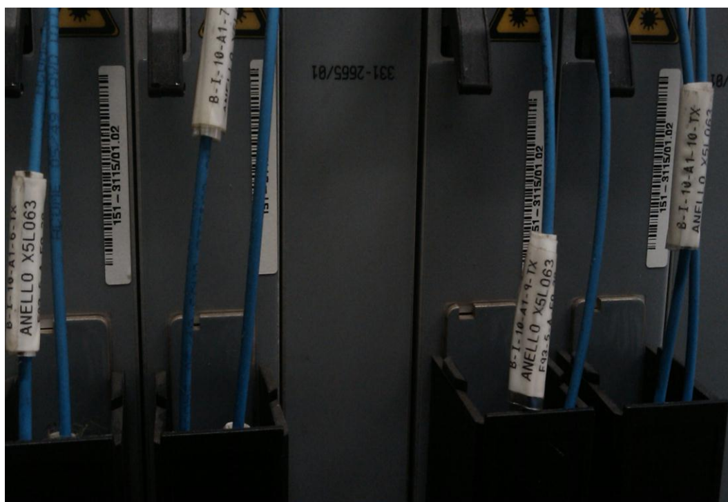
Figura 71: Modalità di Etichettatura delle bretelle F.O.
