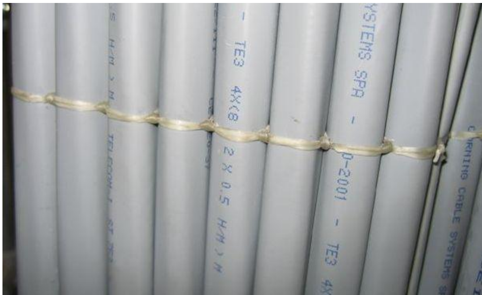
Figura 34: Dettaglio di legatura a “Pacco”
