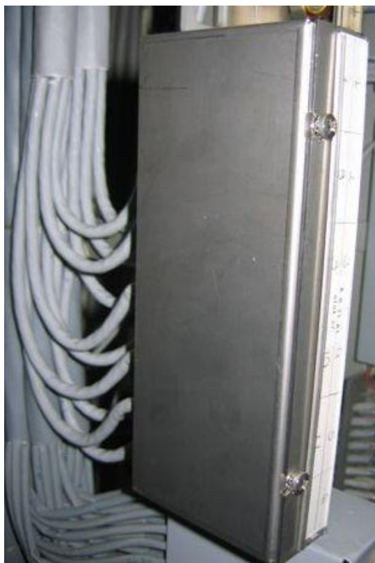
Figura 59: Esempio di sagomatura cavi sul lato verticale
