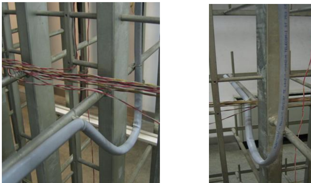
Figura 41: Ricchezza del cavo sulla discesa al PU
