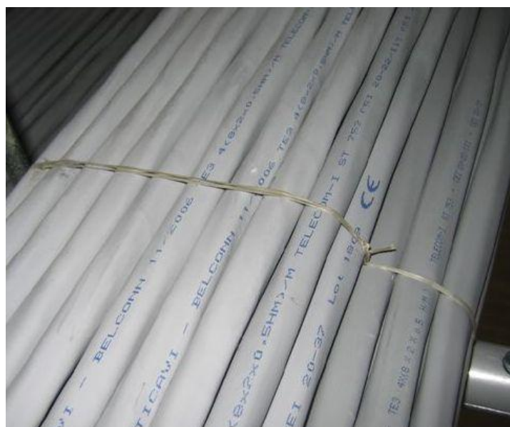
Figura 31: Dettaglio di legatura a “Fascio”
