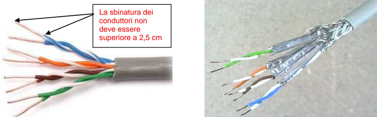
Figura 56 – Esempio di sguainatura del cavo UTP/STP
