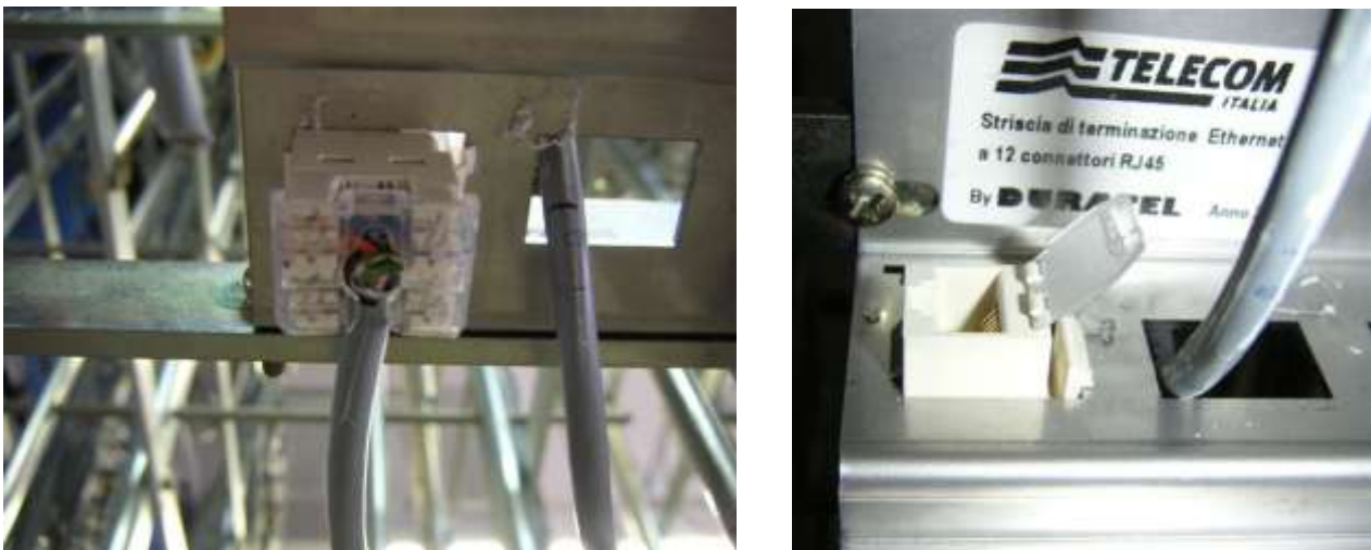
Figura 64 – montaggio connettore su supporto striscia
