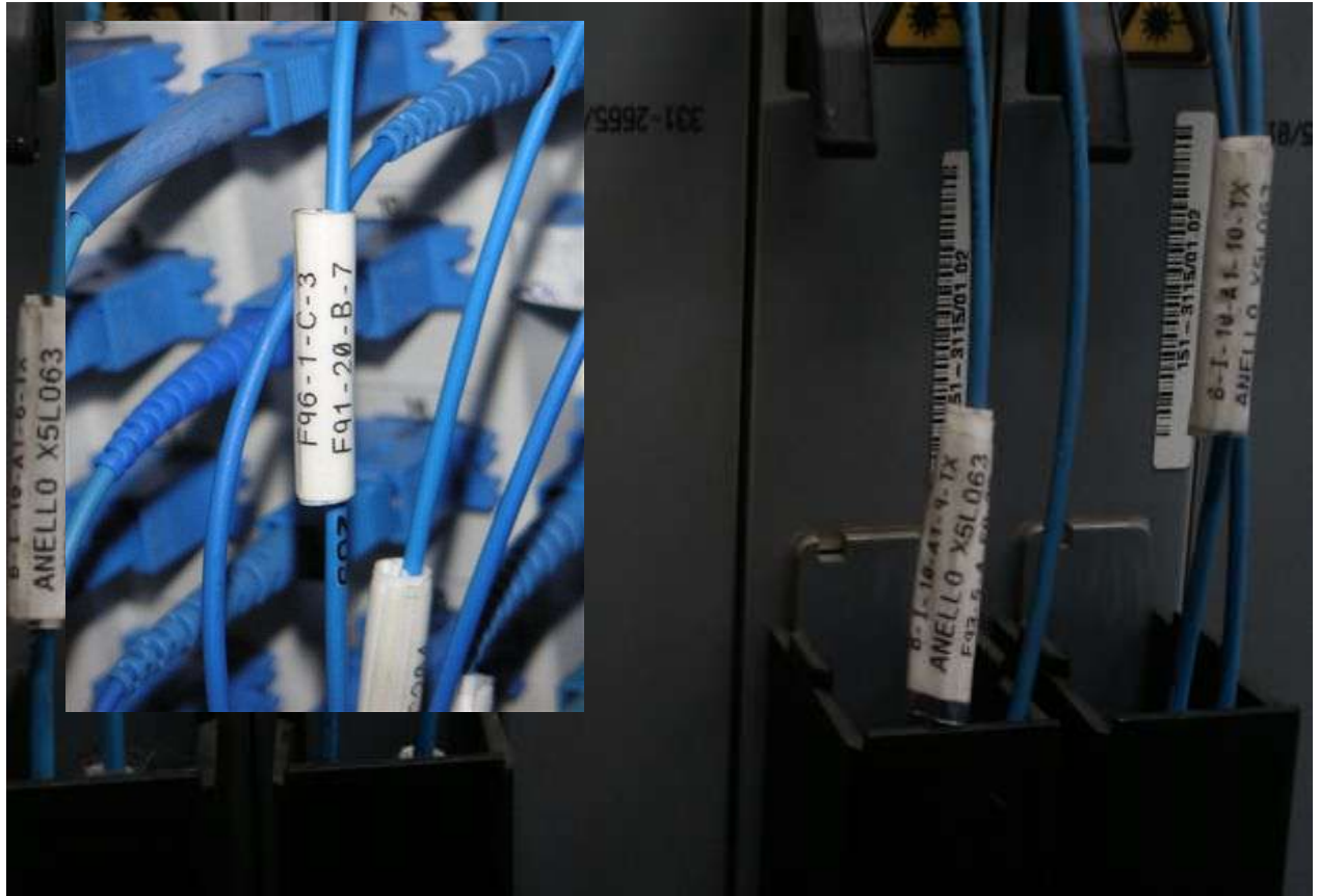
Figura 71 – Modalità di Etichettatura delle bretelle F.O.
