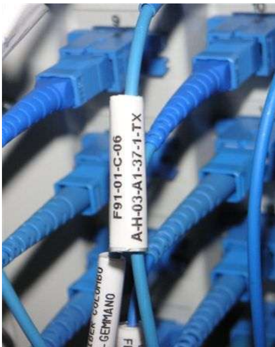
Esempio di Collegamento Rip. Ottico – Apparato
