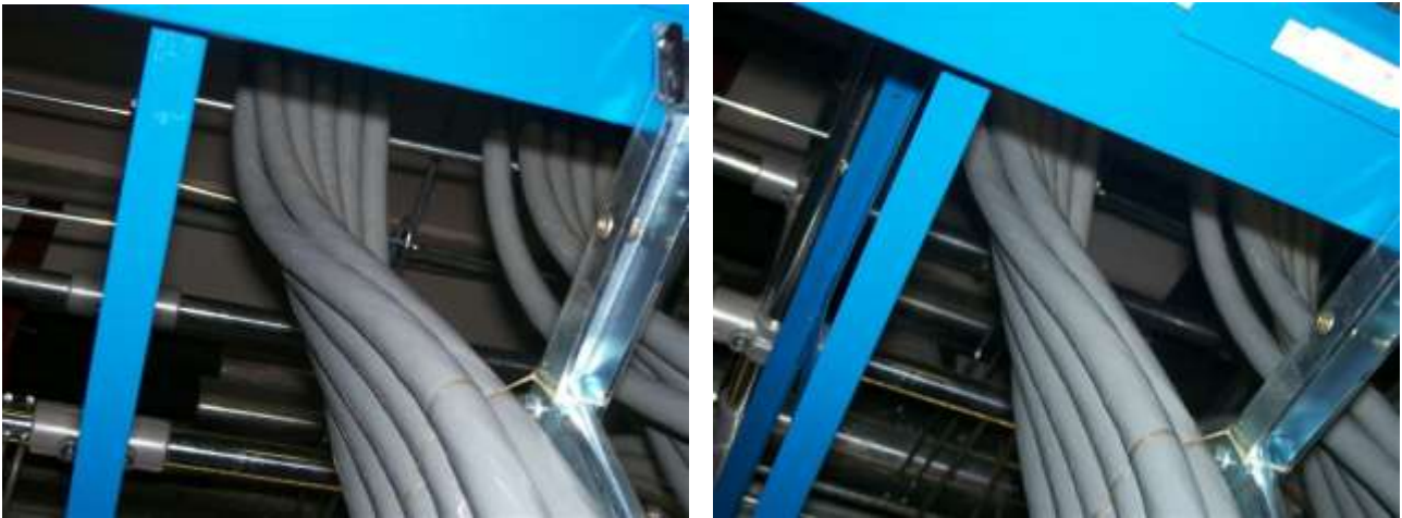
Figura 25 – Esempio di posa dei cavi ad elica
