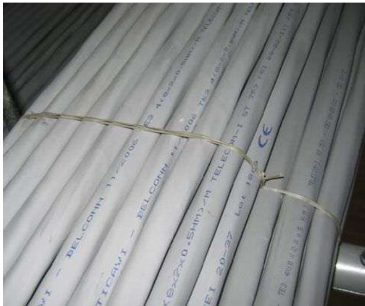
Figura 31 – Dettaglio di legatura a “Fascio”
