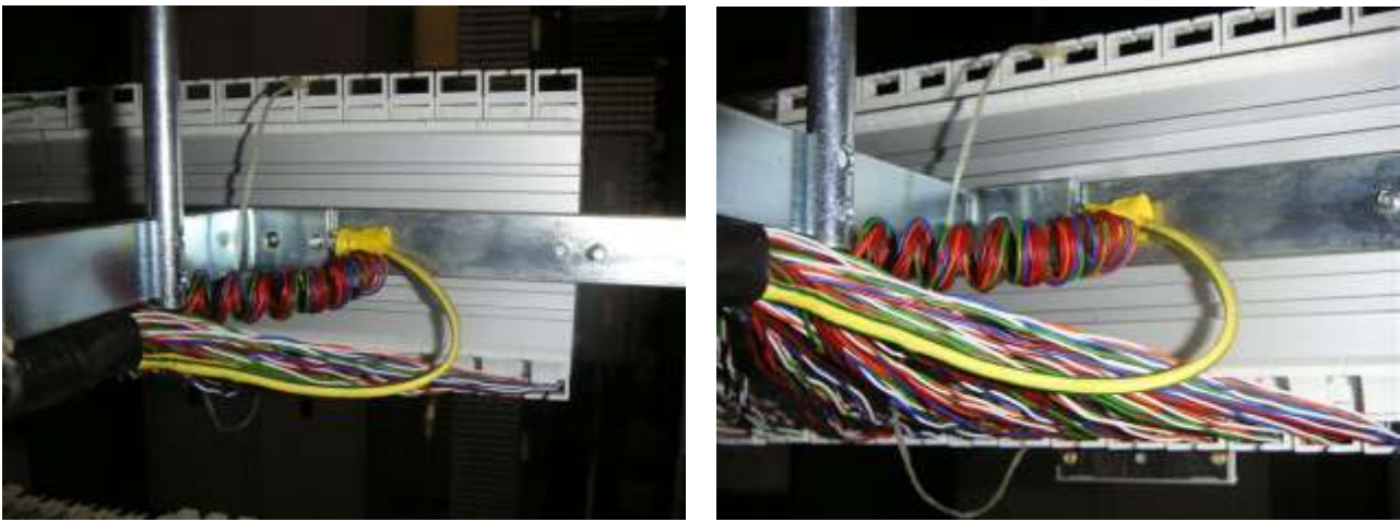
Figura 42 – Coppie di scorta avvolte in un'unica spiralina dietro la striscia IDC
