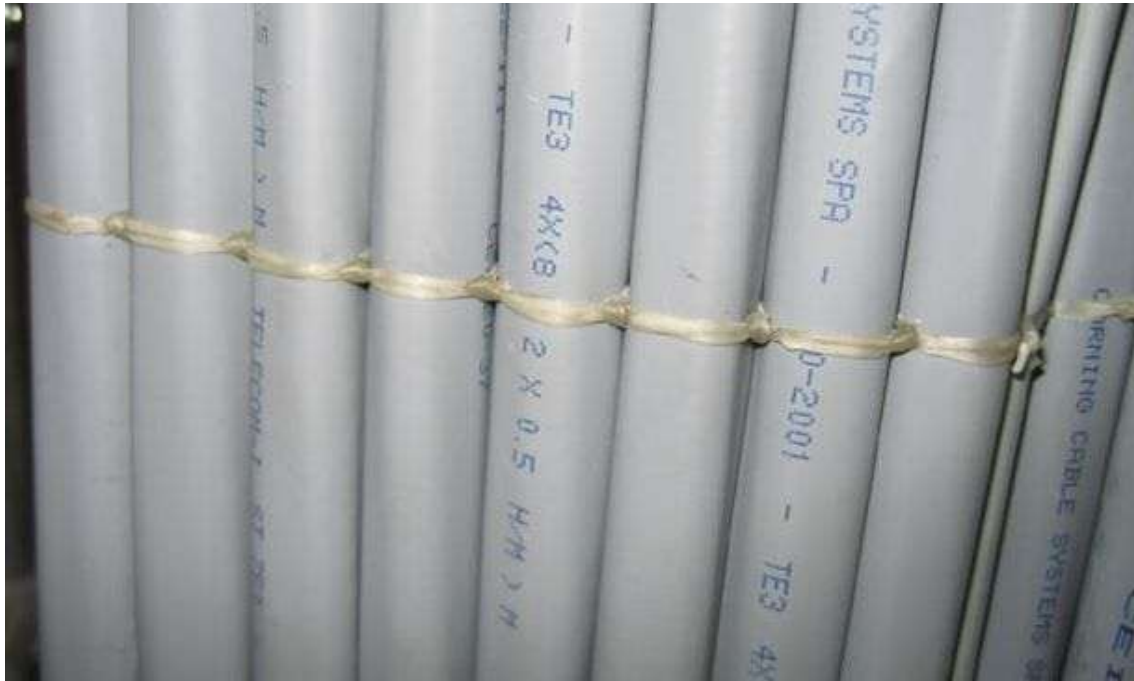
Figura 34 – Dettaglio di legatura a “Pacco”
