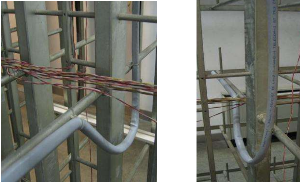
Figura 41 – Ricchezza del cavo sulla discesa al PU
