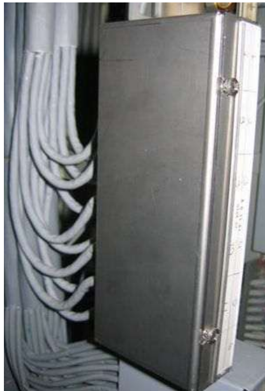
Figura 59 – Esempio di sagomatura cavi sul lato verticale
