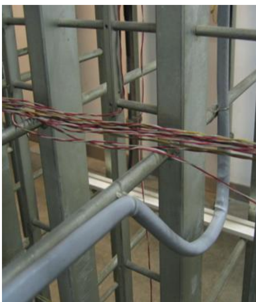
Figura 41 – Ricchezza del cavo da eseguire nei raccordi ULL sulla discesa al PU
