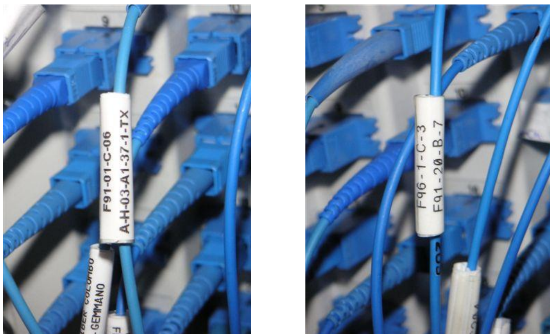
Figura 70 – Modalità di Etichettatura delle bretelle F.O.
