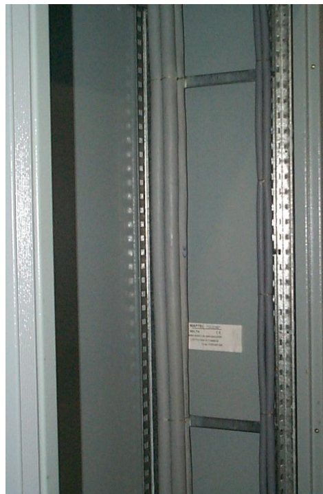
Figura 32 Legatura a “Fascio” interna alle fiancate del telaio
