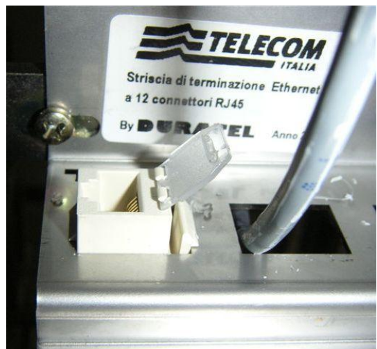
Figura 64 – montaggio connettore su supporto striscia
