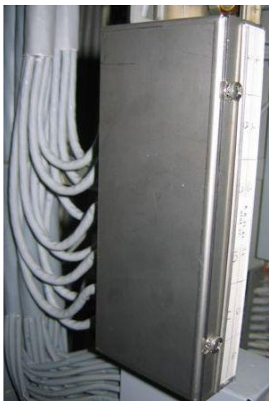
Figura 59 – Esempio di sagomatura cavi sul lato verticale
