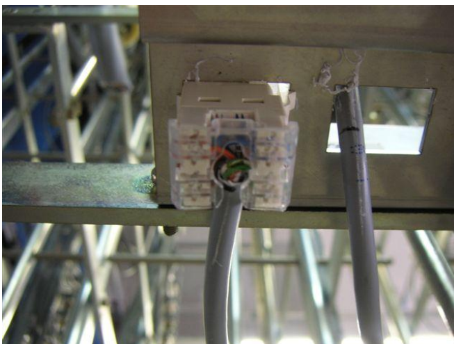
Figura 64 – montaggio connettore su supporto striscia
