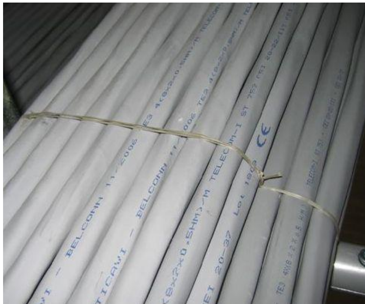
Figura 31 Dettaglio di legatura a “Fascio”
