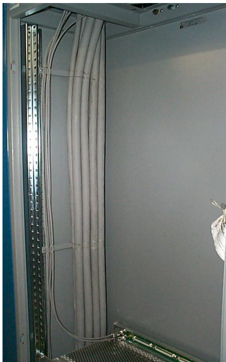
Figura 32 Legatura a “Fascio” interna alle fiancate del telaio
