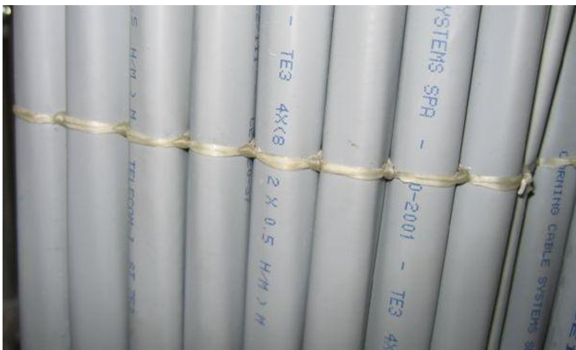
Figura 34 Dettaglio di legatura a “Pacco
