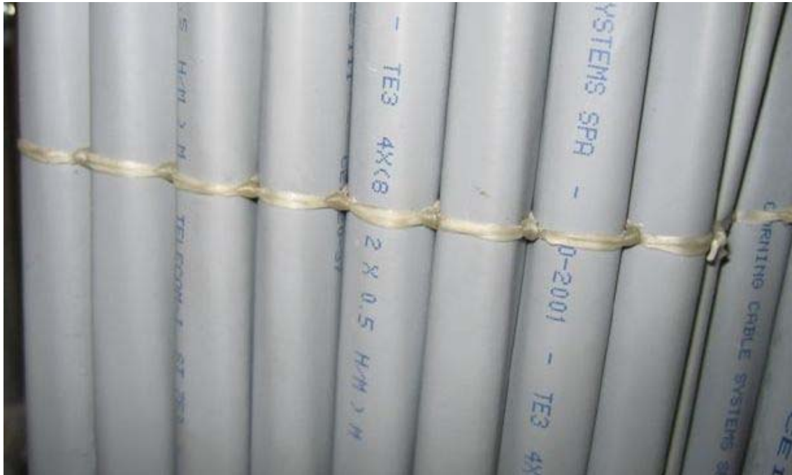
Figura 34 Dettaglio di legatura a “Pacco
