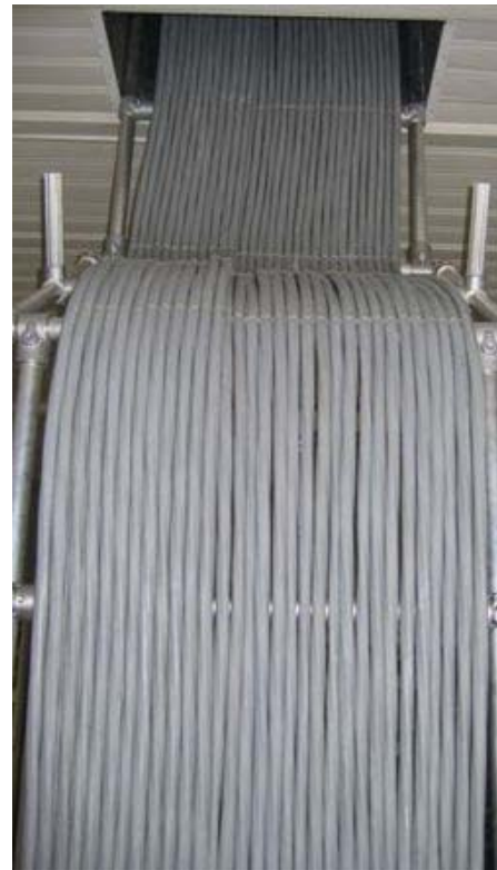
Figura 24 Esempio di posa orizzontale e verticale con pacco cavi omogeneo e compatto
