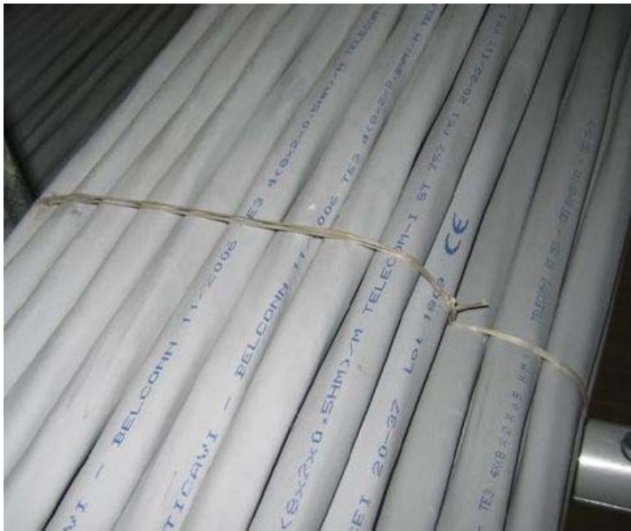
Figura 31 Dettaglio di legatura a “Fascio”
