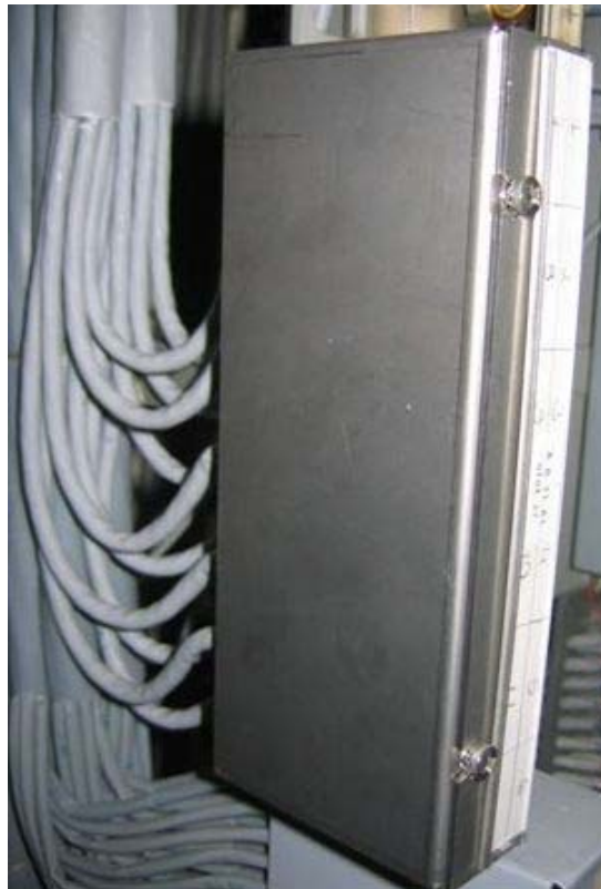
Figura 59 – Esempio di sagomatura cavi sul lato verticale
