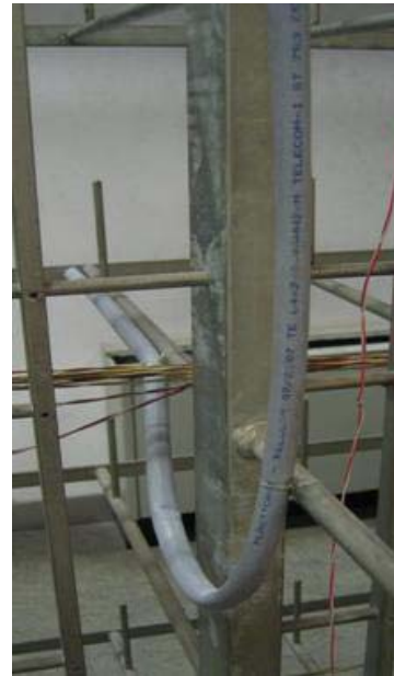
Figura 41 – Ricchezza del cavo da eseguire nei raccordi ULL sulla discesa al PU
