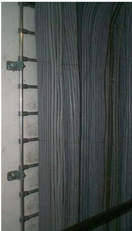
Figura 24 Esempio di posa orizzontale e verticale con pacco cavi omogeneo e compatto
